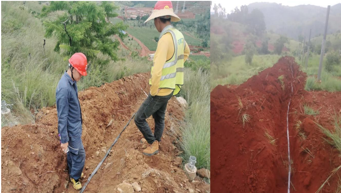
光伏厂区主接地网敷设
