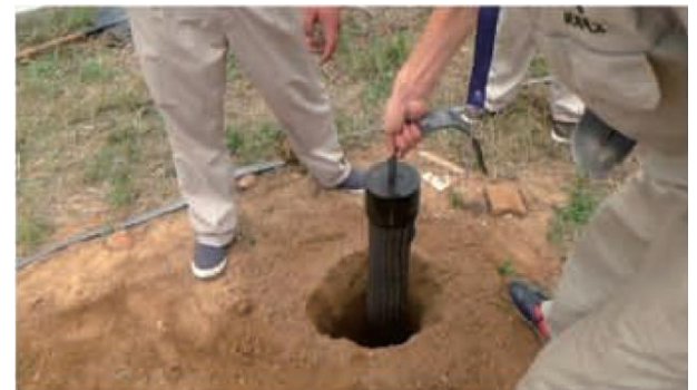
水平接地带和垂直接地极的敷设
