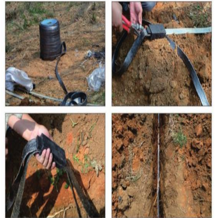
220kV杨柳~柳北线施工现场
