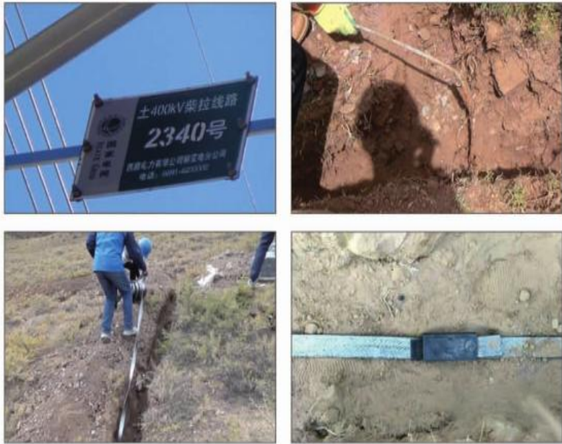
柴拉直流 ±400kV 施工现场
