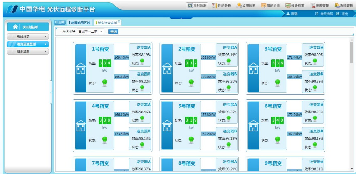
图3 箱变逆变监测界面
