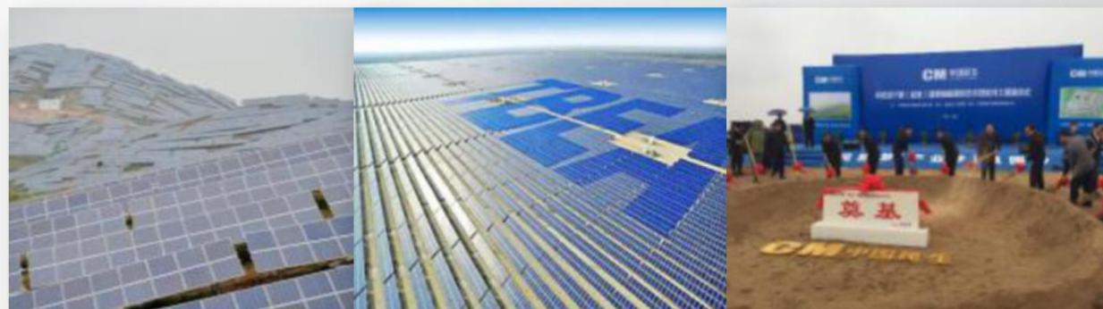
2013年 曲阳项目 50MW
