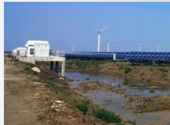
盐城天合响水45MW:高盐雾、高湿度
