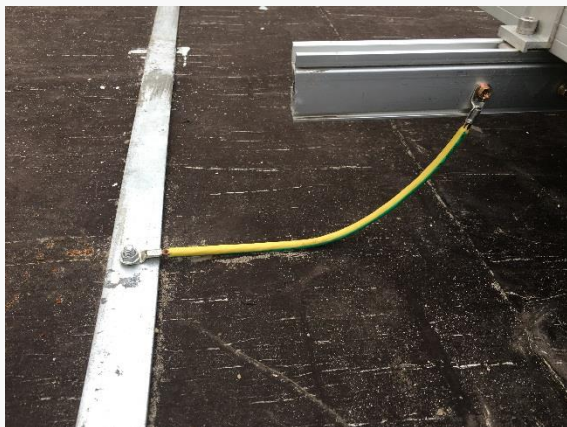
系统接地使用黄绿线
