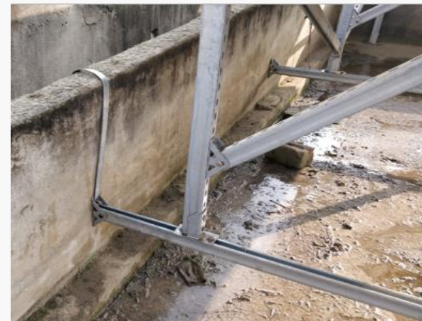
支架固定在女儿墙上
