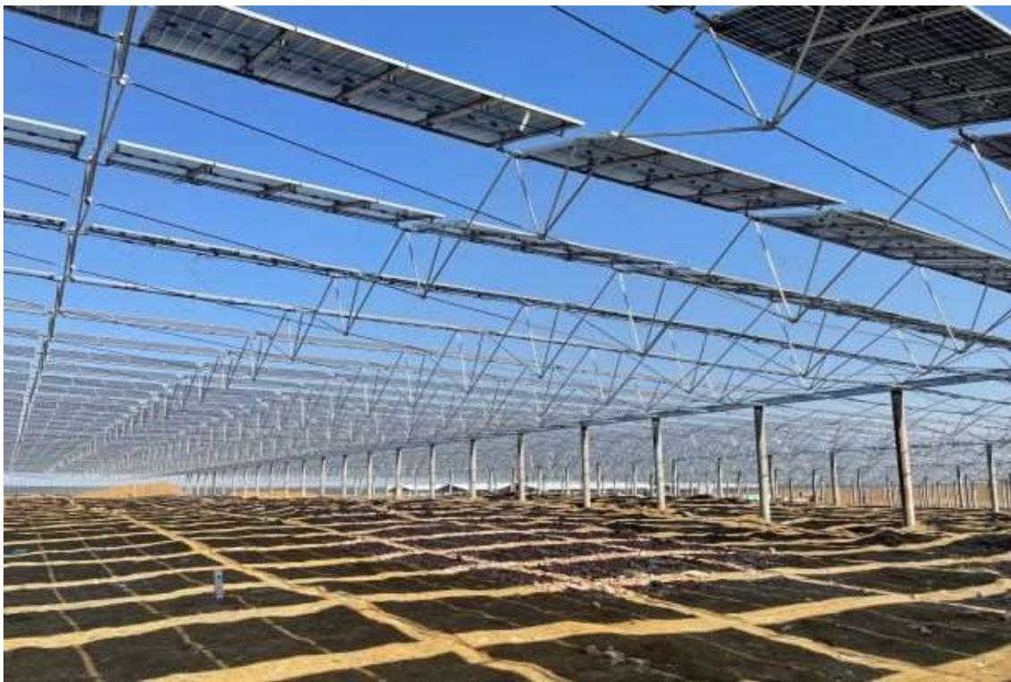
采用“悬、拉、挂、撑、压”的空间结构技术，以柔性预应力钢绞线及刚性撑杆整体组合联结，辅以固结中间梁柱及强力地锚，构成东西向大跨距（36~60m）桁架、组件带倾角无垂度光伏支架系统。
