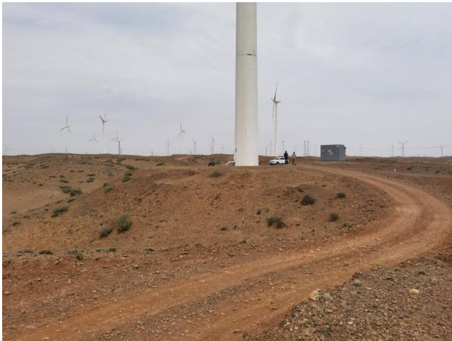
全国首个“以大带小”技改项目-龙源电力宁夏贺兰山项目现场退役老旧机组
